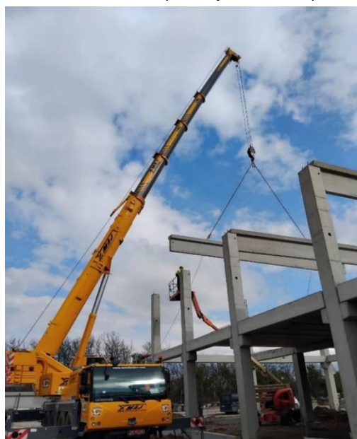
SLIKA 8 – AUTODIZALICA LIEBHERR 1070 - 4.2 SA TELESKOPSKOM GRANOM, U RADU NA GRADILIŠTU U LESKOVCU, 2025. god.
