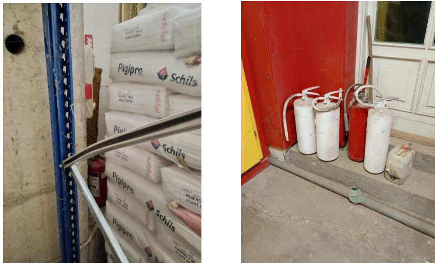
Слика 3. Последице запуштања мобилних уређаја за гашење пожара
