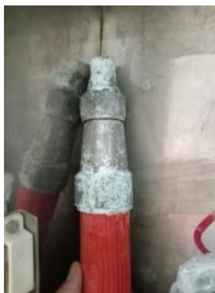
Слика 2. Последице запуштања система хидрантске мреже за гашење пожара
