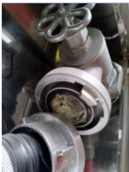
Слика 2. Последице запуштања система хидрантске мреже за гашење пожара
