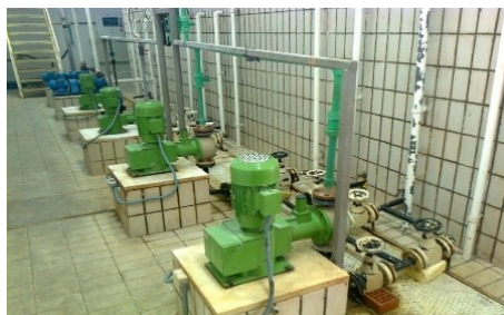
СЛИКА 8 - Пумпе и опрема за припрему и дозирање хемикалија [2]
