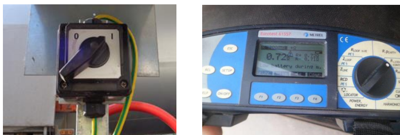
SLIKA 10 - KONTROLA PROCESA UZEMLJENJA AC SA OBJEKTOM U TOKU ISTAKANJA ND
